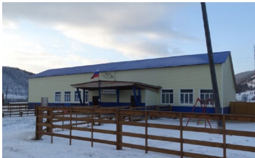
Отремонтированный Дом культуры, Бугульдейское муниципальное образование Иркутской области
